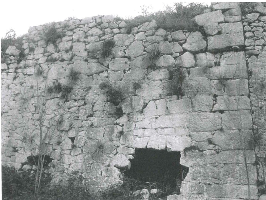
Fronte O del terrazzamento principale, cantonale in poligonale di quarta maniera con ai lati addossate e in fase specchiature in opus incertum
