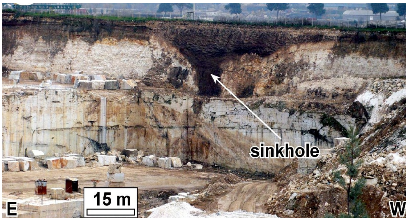
Fig. 8 - Sinkhole nella formazione della testina (da Faccenna et al., 2008; foto F. Poggi).
