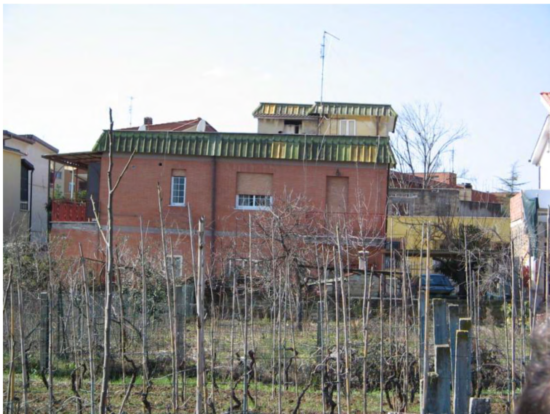
Fig. 13 - Evidente cedimento differenziale in un edificio presso Villalba di Guidonia. Si noti che il piano inferiore è più ruotato rispetto al superiore lasciando ipotizzare che il cedimento sia avvenuto in corso di costruzione. L'abitazione si trova in corrispondenza di una delle depressioni morfologiche riconosciute dall'analisi delle foto aeree (foto L. De Filippis).
