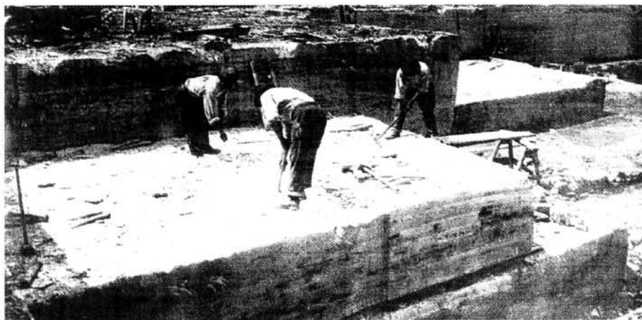
Fig. 5 - Moderni cavatori «riducono» un masso in blocchi più piccoli (prima metà '900).
